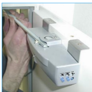
4. Zahnstange in den Türantrieb einschieben.
