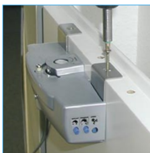
2. Türantrieb anschrauben.
